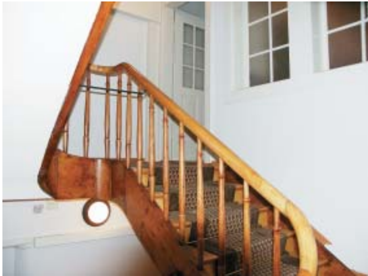
Oben rechts befindet sich die Waschküche.
