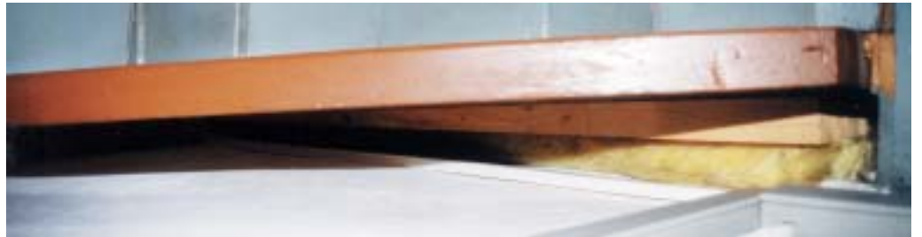
Undicht abgedeckte Glaswolle. Praktisch in jedem Haus zu finden.
