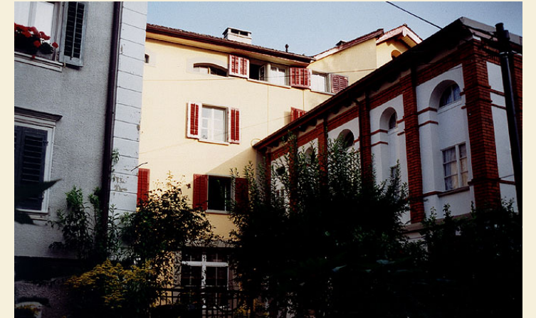
Die Ostseite der Alten Brauerei mit angebautem Rossgaden rechts.
